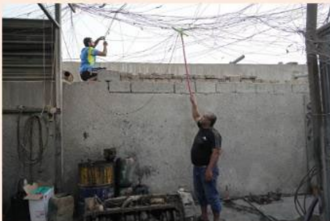
Ben elektricien in Beograd sluit een dieselgenerator aan. In het Midden-Oosten zijn door problemen met het stroomnet veel generatoren. Foto: AP Photo / Hadi Mizan
